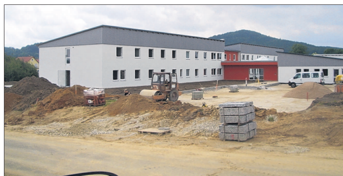
In Königstein erstellt Plan-Bau eine Behinderteneinrichtung für geschlossene Pflege und Wiedereingliederung.
